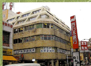
■テナントビル施工前
